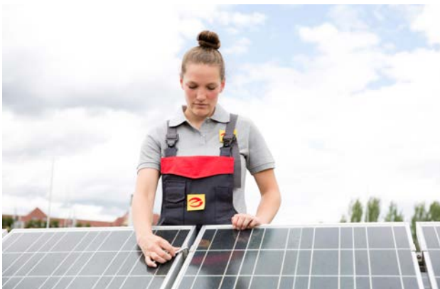
Abbildung 7: Befestigen der Schrauben an der Photovoltaikanlage (Quelle: ZVEH)
