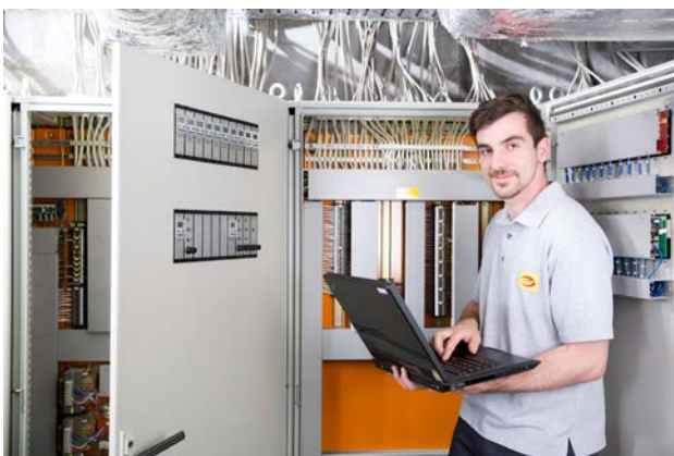
Abbildung 8: Programmierung einer Anlage der Automatisierungstechnik (Quelle: ZVEH)
