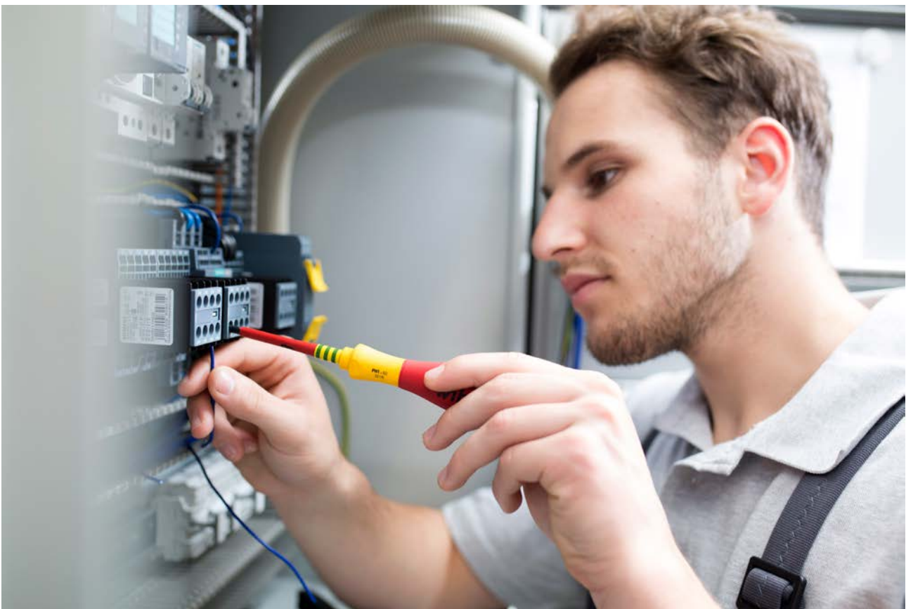
Abbildung 4: Arbeiten am Schaltschrank (Quelle: ZVEH)
